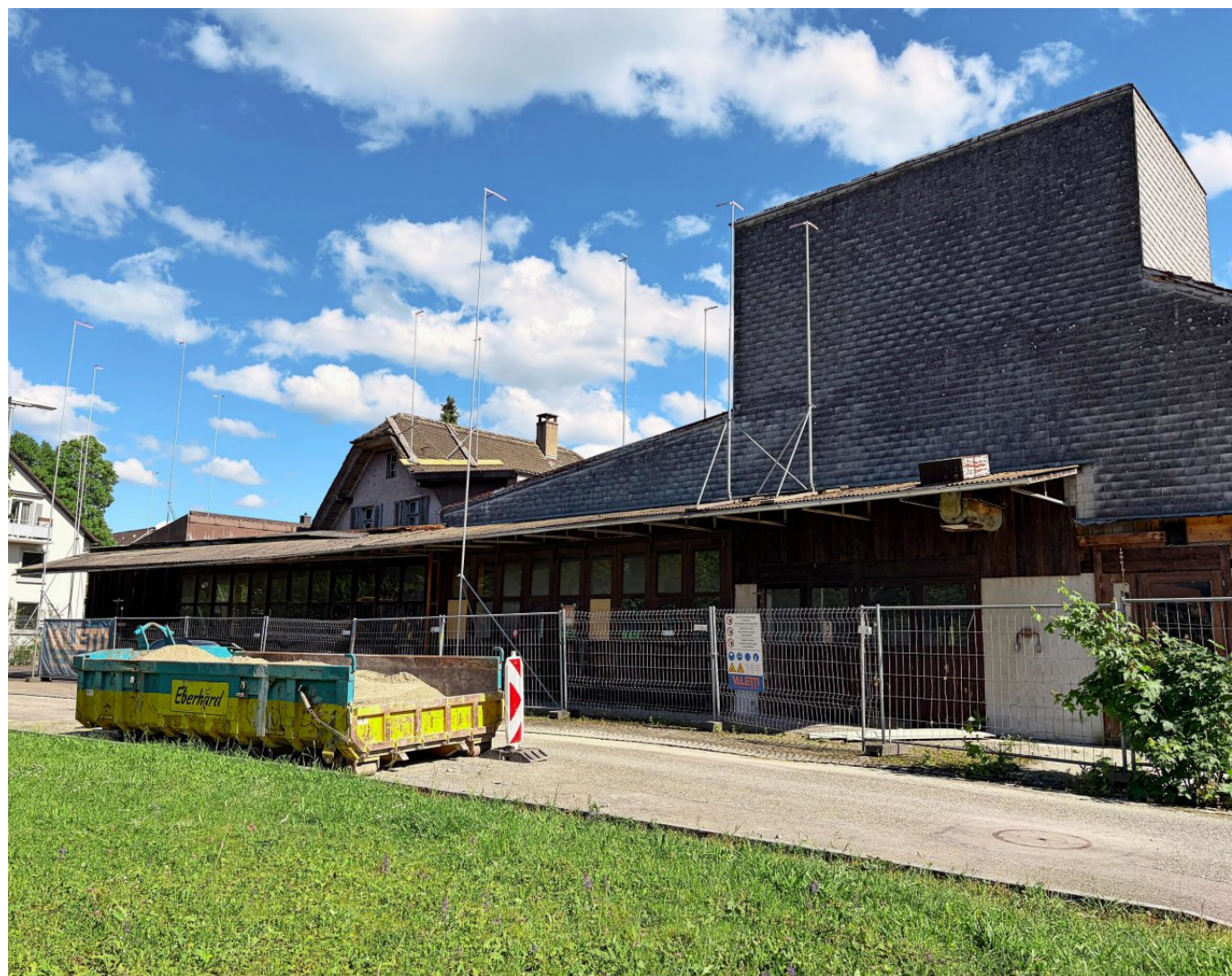
Am Wallweg sind insgesamt 29 Wohnungen geplant. Dafür wird die bestehende Liegenschaft abgerissen.
