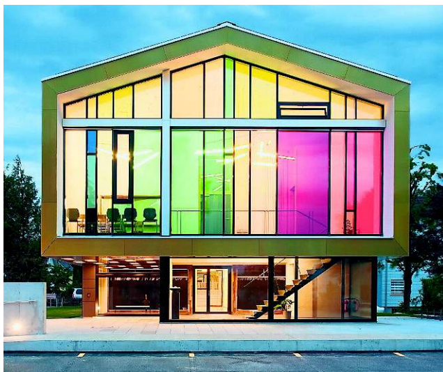
Umbau Neuapostolische Kirche in Staufen.
