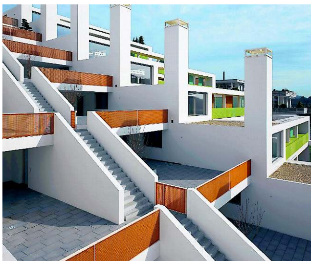
Terrassenbauten Allmend, Eichtalboden, Baden.
