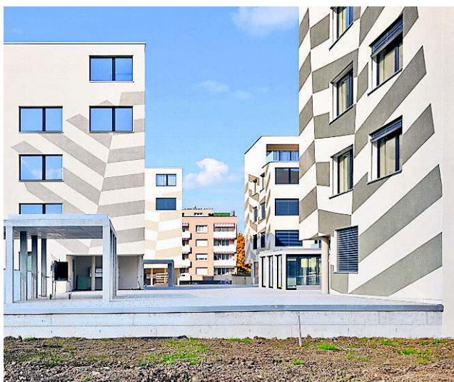
Dockland: 36 neue Wohnungen in Villmergen.
