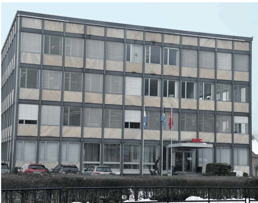
Das Verwaltungsgebäude wird ersetzt durch einen Neubau
