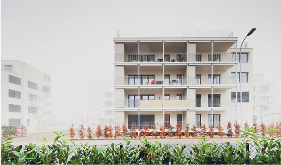
Leicht erhöhte Lage: Die Überbauung musste wegen des Grundwassers herausgehoben werden
