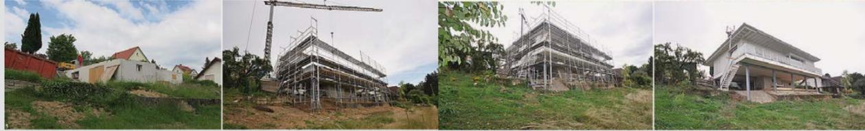
Vier Phasen des Ersatzneubaus: Zuerst wurde das bestehende Haus bis auf das Kellergeschoss zurückgebaut, danach konnten die vorgefertigten Holzelemente auf das Untergeschoss und die zusätzlichen Stahlstützen gestellt werden. Die reine Bauzeit vor Ort war von Juni bis Oktober, inklusive Abbruch und Vorbereitungsarbeiten.
