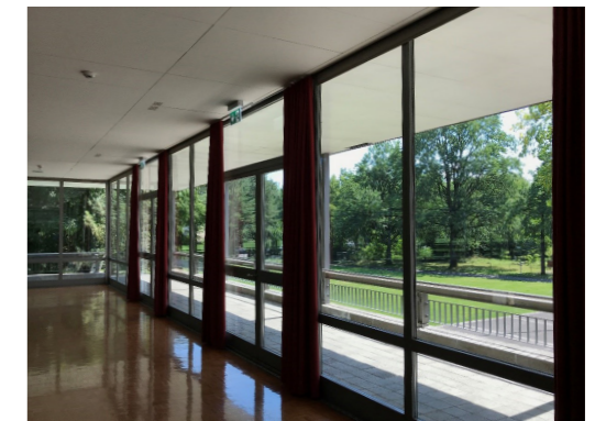
Aula Fassade Obergeschoss
