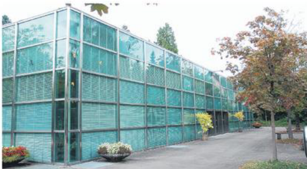
Die grosse Abdankungshalle auf dem Aarauer Friedhof Rosengarten wird ab 1. Oktober saniert.
