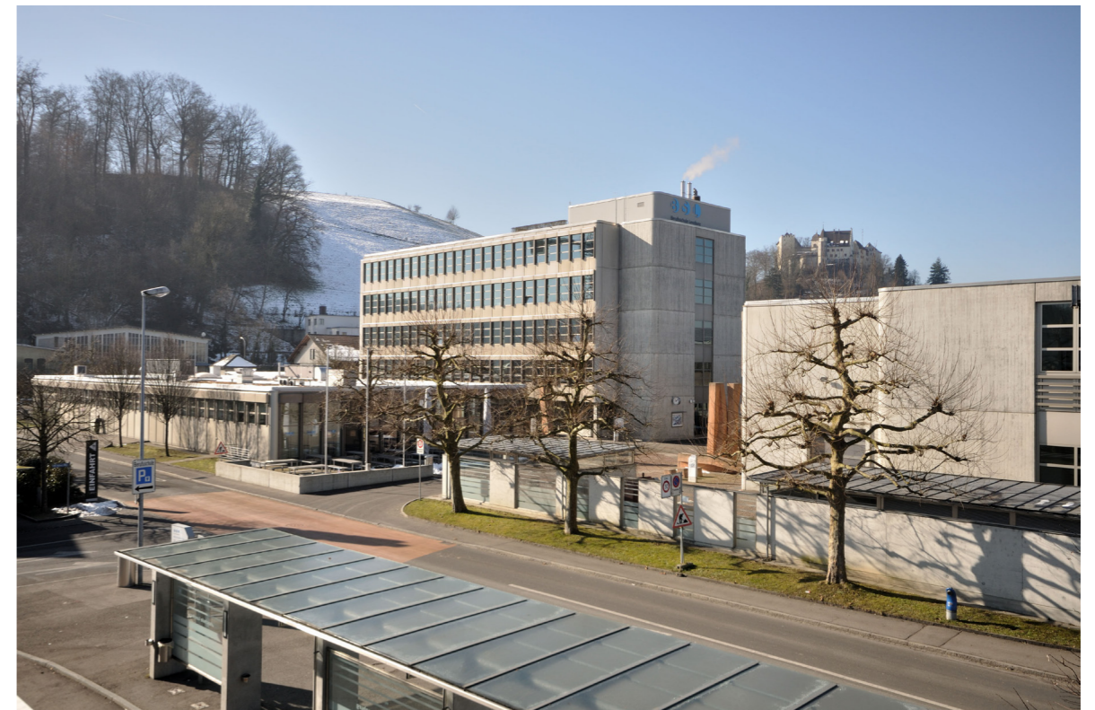
Fassade mit Aluminiumfenstern
